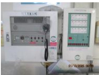
7.Fire detector central control.JPG
